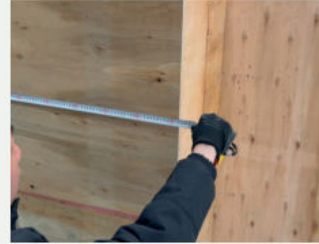
①시공 위치 측정 및 평탄화
